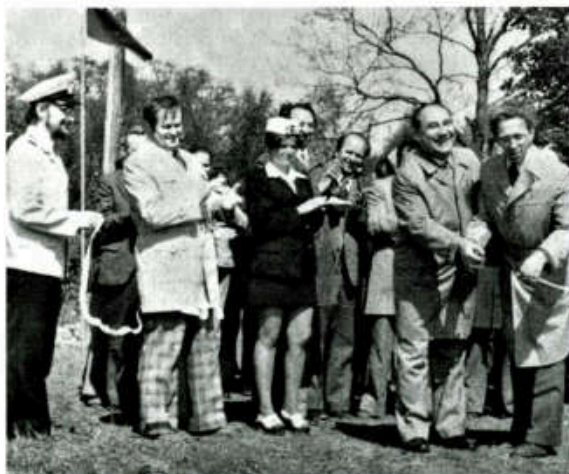
Übergabe des ersten Bauabschnittes
