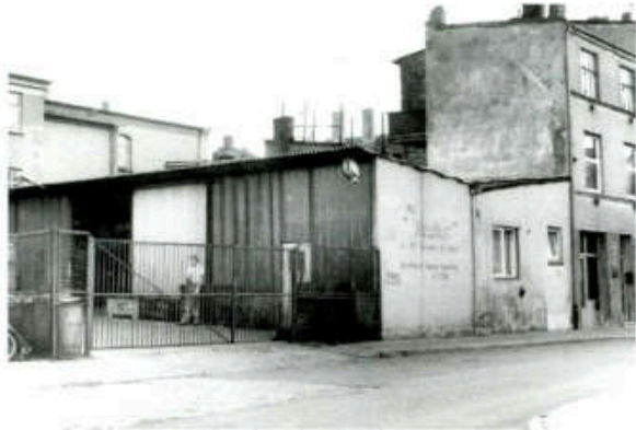
Die erste DSR-Werkstatt für Maschinenbau- und Rohrschlosserarbeiten.
