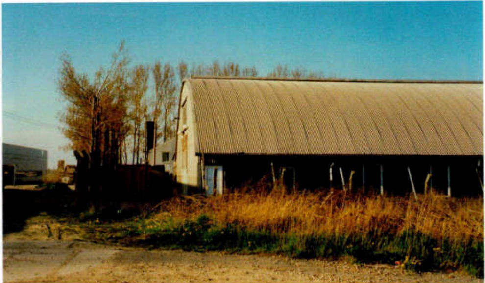
Die erste von der DSR in Kritzmow nahe Rostock im Jahre 1980 errichtete Halle für die Konsumgüterfertigung.
