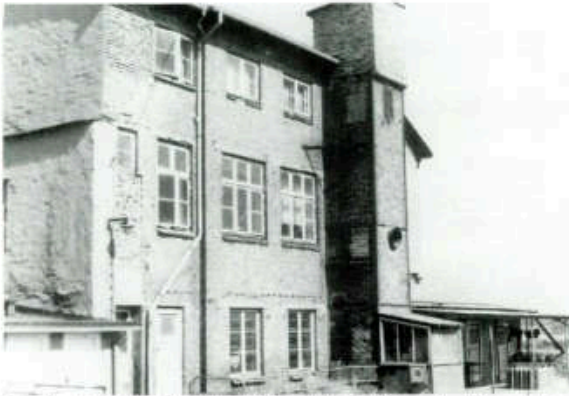
Am Standort „Alter Markt“ richteten sich die Kältewerkstatt und das Betriebsmittellabor ein.
