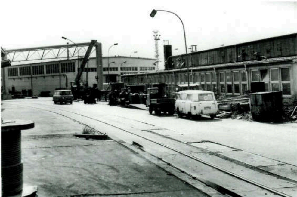
Die ersten technischen Werkstätten im Überseehafen Rostock.
