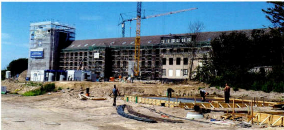
Bauarbeiten an der ehemaligen Seefahrtsschule Wustrow (Sommer 2018)
