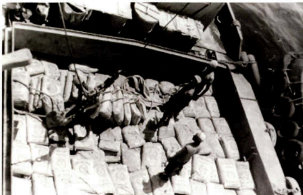
Das Löschen von Zement auf Dubai Reede
