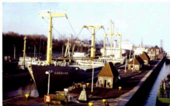
In der Schleuse Brunsbüttel
