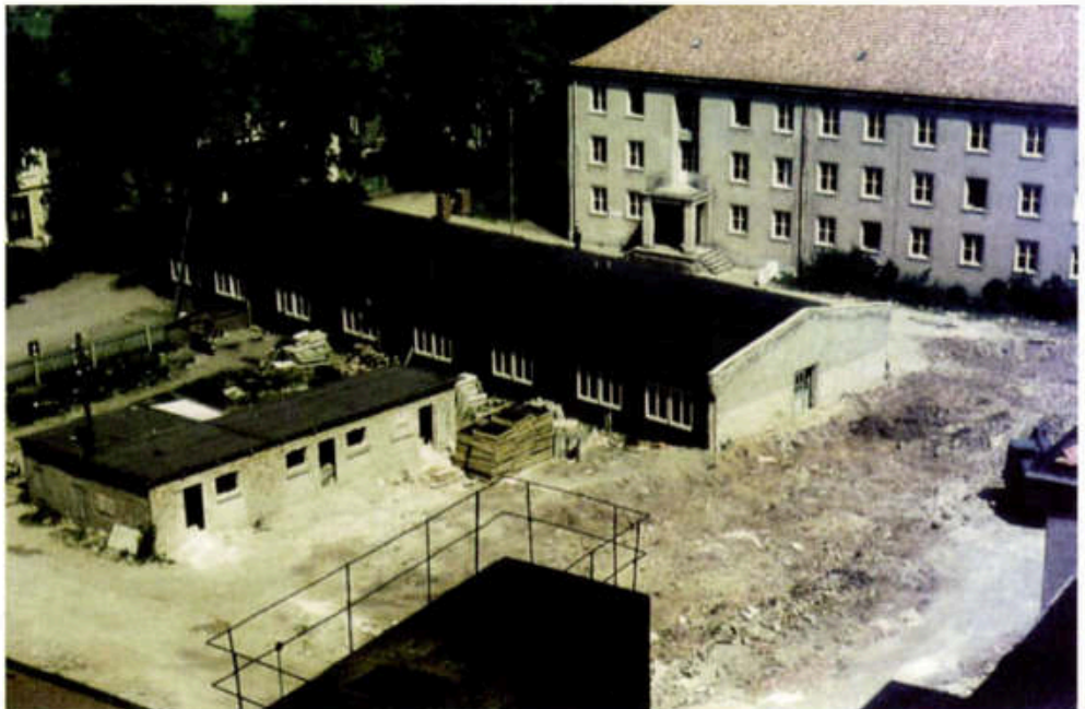
Blick auf den Hof der Seefahrtsschule
