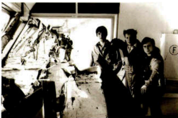
In der beschädigten Veranda, li.: ein Lehrling, Mitte: der Autor, re.: Dreher Klaus Schuster
