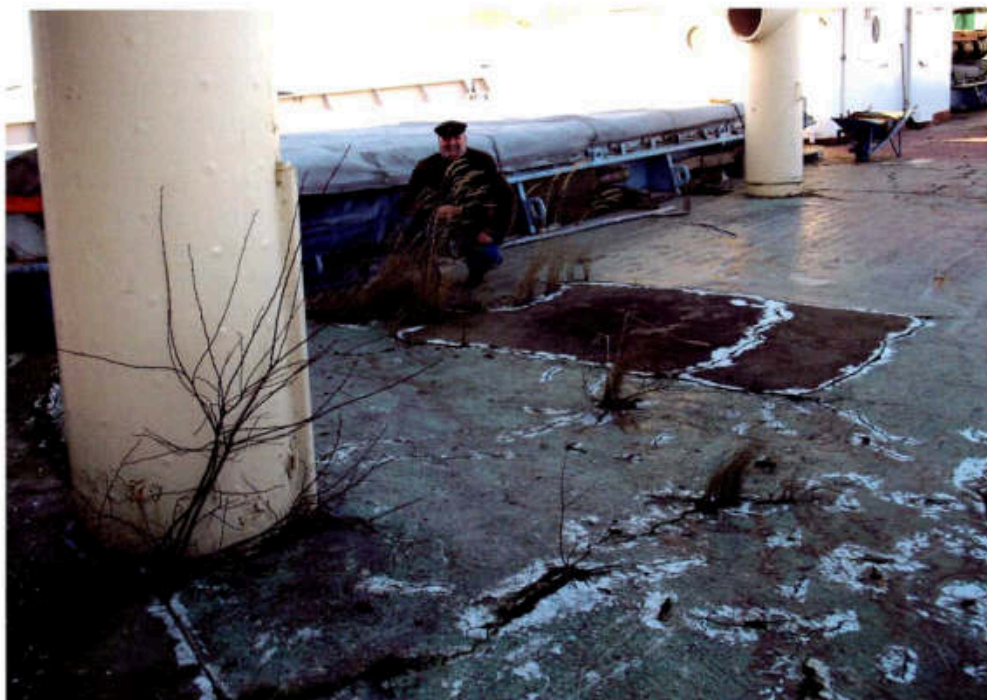
Zustand des Oberdecks im Januar 2013
