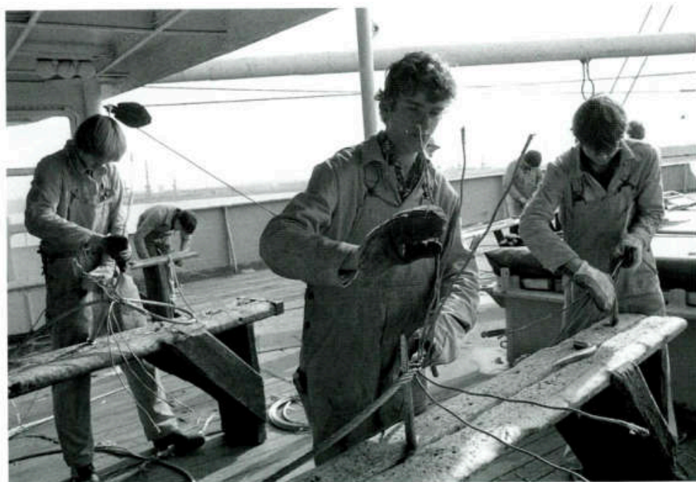
Lehrlinge beim Spleißen von Drahttauwerk während der Ausbildung (GEORG BÜCHNER, 1981)
