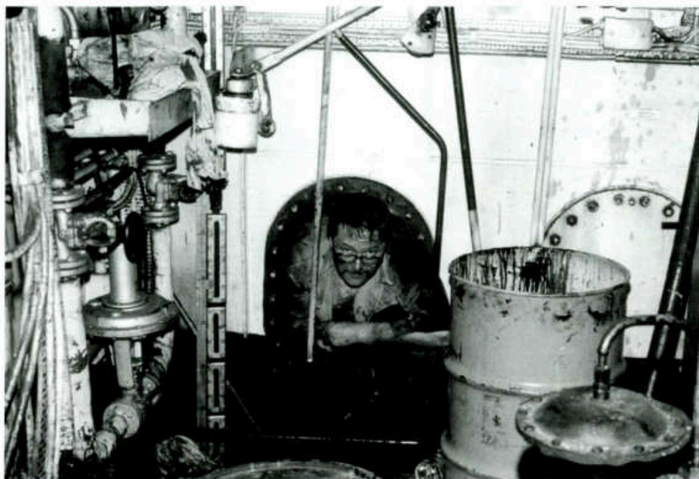
Kurt-Werner Langer bei der Reinigung HD-Tagestank Typ XD (MS ROSTOCK, 1985)
