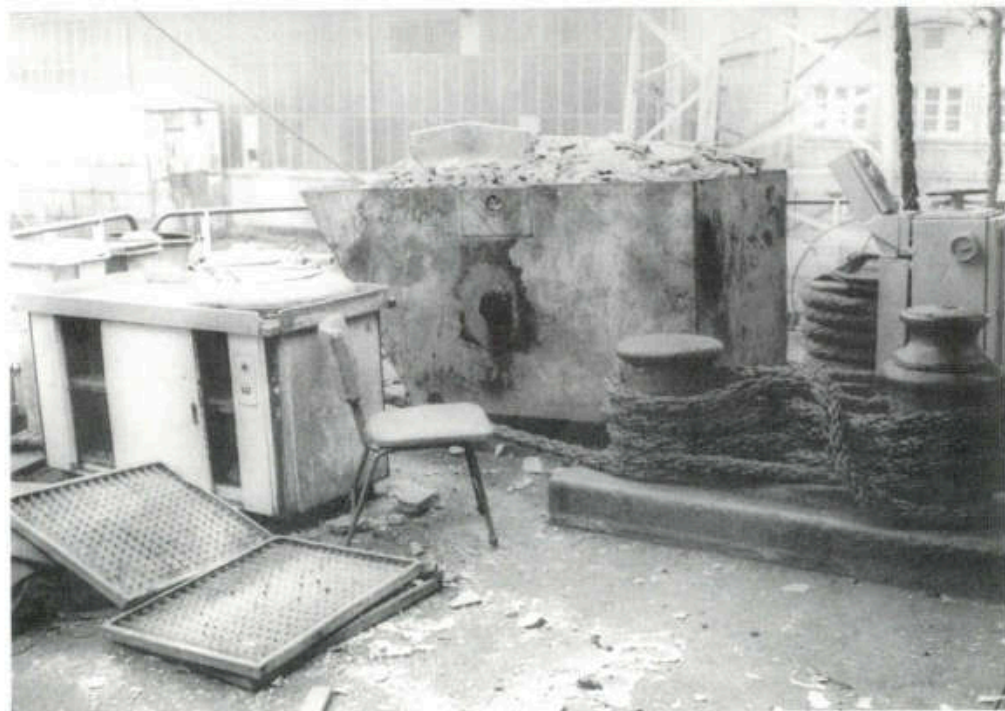
Bauzustand während der Entkernung des Schiffes
