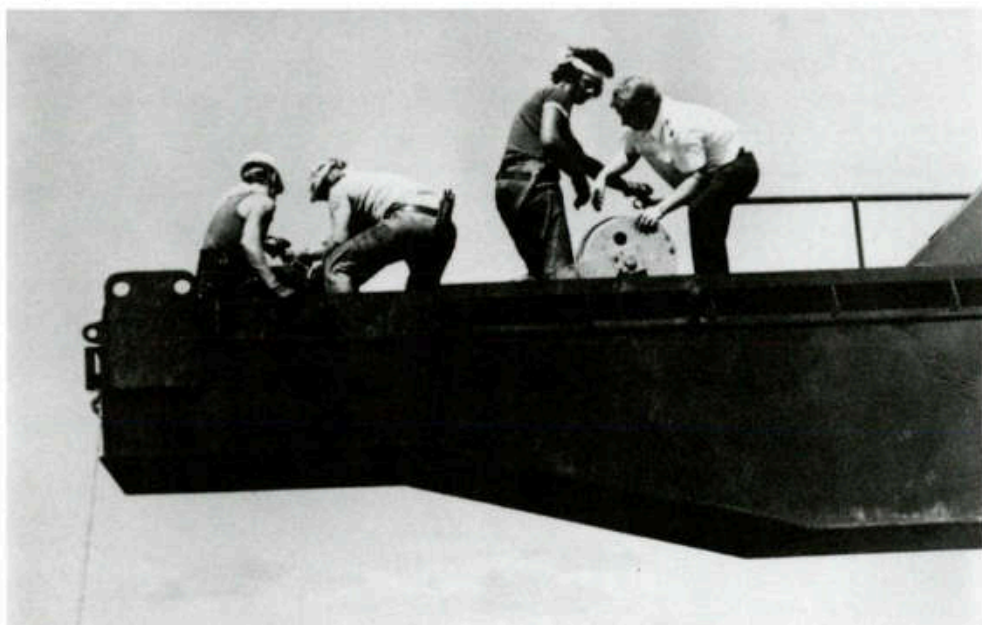
Wechseln der Auslegerblöcke
