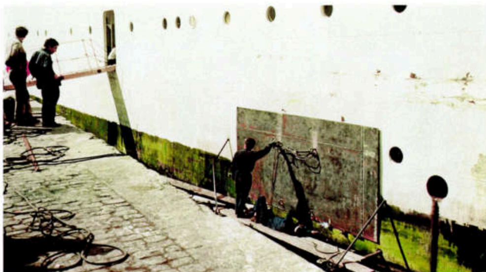
Reparaturarbeiten an der Außenhaut in Teneriffa
