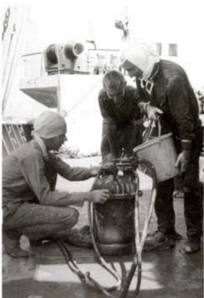
Konservierungsarbeiten auf MS RONNEBURG, Anfang der 70er Jahre
