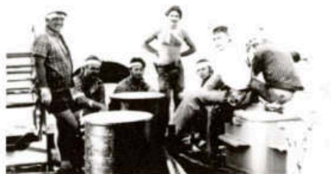
Arbeitspause für die Crew nach vielen vergeblichen Schleppversuchen.
