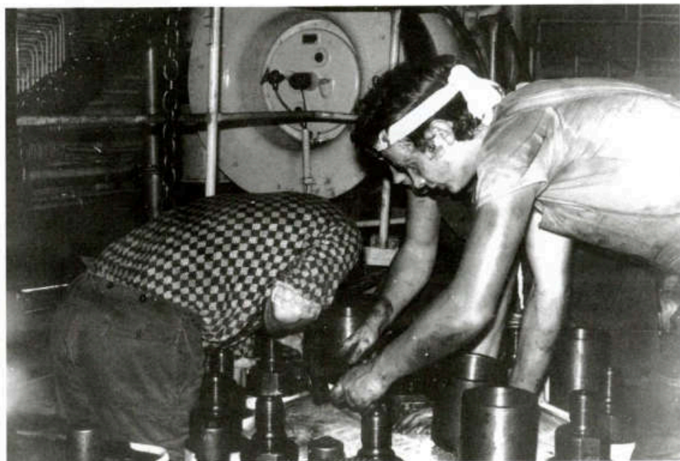
Vorbereitung zur Demontage eines Zylinderdeckels
