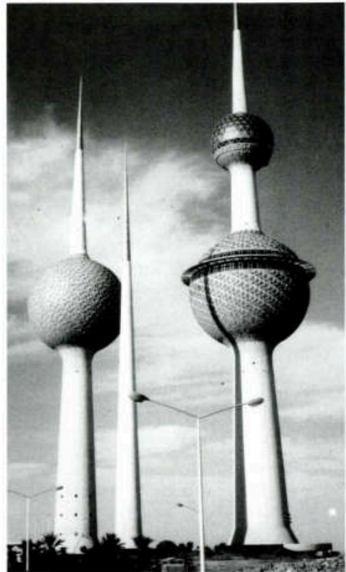
Die Wassertürme – Wahrzeichen von Kuwait
