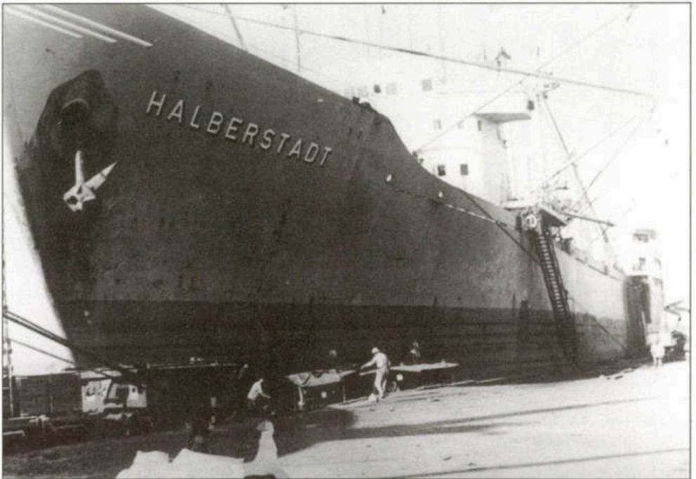
MS HALBERSTADT – Vorbereitung zur Reparatur im Hafen Haiphong
