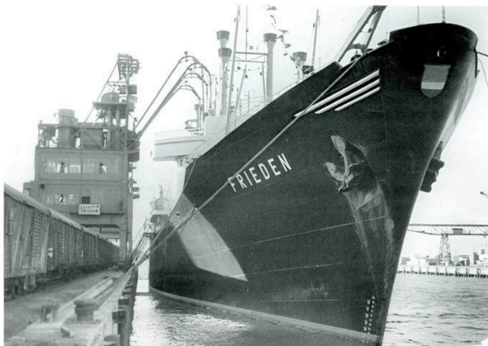
Oktober 1957: Der erste Portalsaugturm der größten pneumatischen Löscheinrichtung für Getreide in der DDR wurde am 3. 10. 1957 im Hafen von Wismar vorfristig in Betrieb genommen. Die Saugrüssel der Anlage, die in einer Stunde 150 t Getreide aufnehmen können, senkten sich in die Laderäume des 10.000-Tonnen-Frachters FRIEDEN und schluckten Tonne um Tonne goldgelben, ägyptischen Weizens. Im Hintergrund sehen wir die gewaltigen Saugrüssel der neuen Löschanlage. (BArch, Bild 183-48854-0002/ Wittig/CC-BY-SA)
