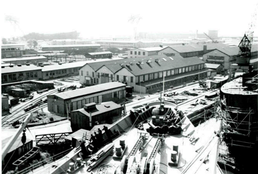
September 1958: In der Warnow-Werft soll ab 1961 jeden Monat ein 10.000-Tonnen-Frachter fertiggestellt werden. Zur Zeit befinden sich neben größeren Exportaufträgen für die sozialistischen Länder mehrere Frachter der „Städteserie“ (10.000 to) im Bau, die in der DDR in Dienst gestellt werden sollen. Unser Bild zeigt einen Blick auf die Warnow-Werft. Im Vordergrund Deckaufbauten der MAGDEBURG. Im Hintergrund die 65 m hohe Kabelkrananlage, die modernste Europas. (BArch, Bild 183-58563-0006/ unbekannt/ CC-BY-SA)
